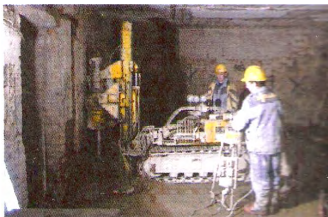
Рис. 3. Работа в подвальном помещении по усилению фундамента
