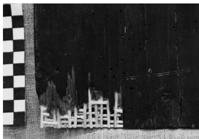
Рисунок 3 – Фрагмент с установленной деревянной арматурой
