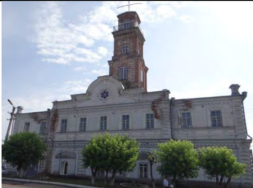
Рисунок 1 – Общий вид главного фасада здания
