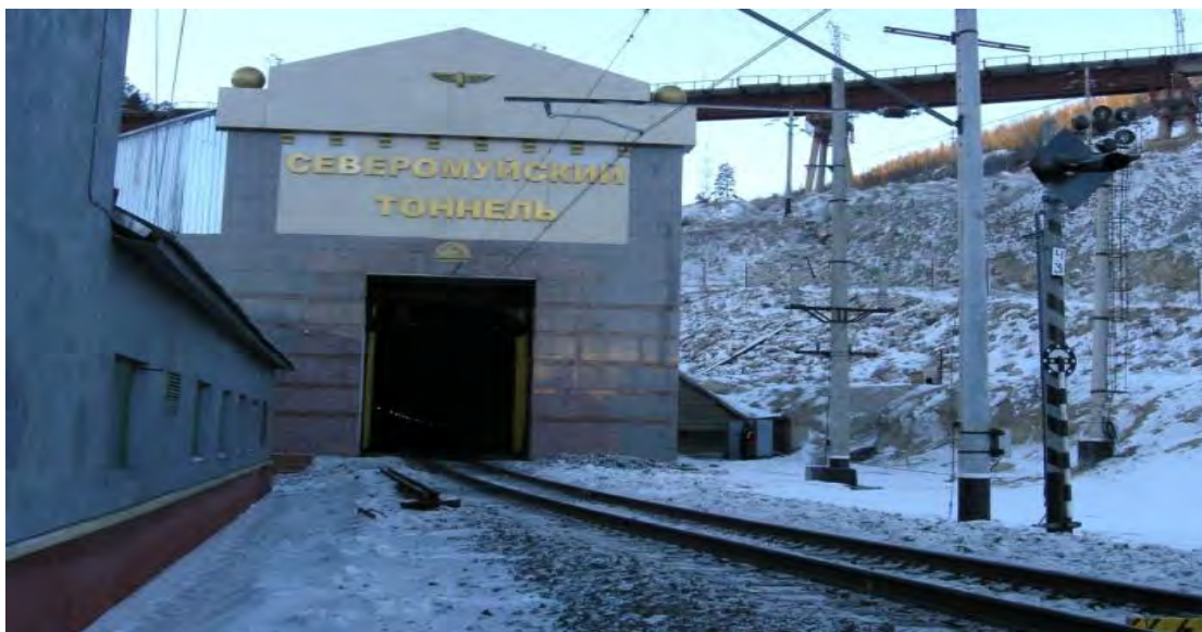
Рисунок 1 – Восточный портал Северо-Муйского тоннеля
