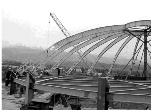
Рисунок 8 – Купол покрытия одиннадцатипятиэтажного здания бизнес-центра в г. Алматы (Казахстан)
