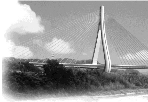
Рисунок 4 – Общий вид подвесного моста «Yahagigawa bridge» (Япония)
