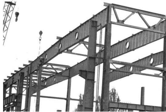
Рисунок 7 – Покрытие здания производственного корпуса завода 20 лет Октября в г. Алма-Ате (Казахстан)
