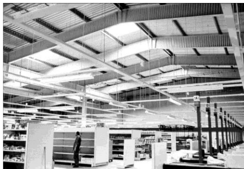
Рисунок 10 – Покрытие торгового центра с балками фирмы «Zeman» (Польша)
