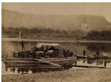
Рис. 7. Ленский сплавной паузок (иначе - подвозок, павозок) самой простой конструкции, набора. На одну навигацию. Конец XIX в. Ленский плоскодонный карбás (карбáз) был по набору такой же, только крупнее. Суда такого примитивного, плотницкого, набора прозвали «утюгами» [3]
