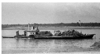
Рис. 9. Самоходный паром (колёсный, с тракторным дизелем на солярке), переделанный из старой деревянной баржи. 1967 г. Фотоснимок В. И. Микшта из архива Ю. Микшта [48]
