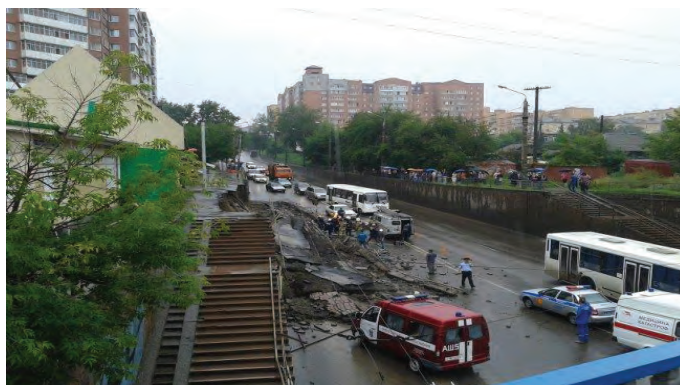
Рисунок 2 - Подпорная стенка г. Красноярск, ул. Проспект свободный
