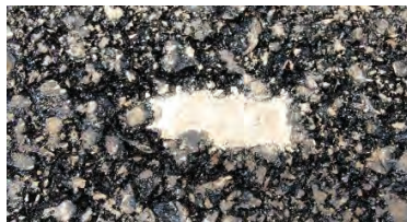
Рисунок 2 – Репер - марка после закладки
