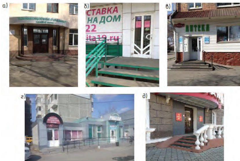
Рисунок 3 – Устройство входных групп с нарушениями норм:
