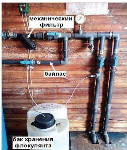
Рисунок 1 – Механический фильтр блока доочистки
