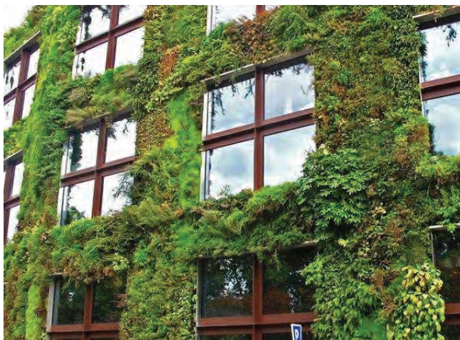
Рис.2. Вертикальное озеленение на биобетоне.
