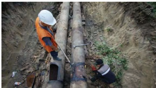
Рис. 1, отказов Ремонт трубопровода
