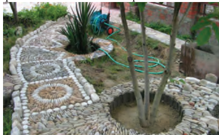
Рис. 5. Пример мощения камнем.
