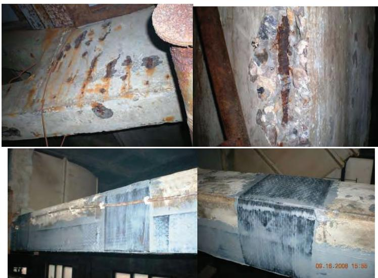
Рис. 2. Применение углепластикового полотна для усиления железобетонной фермы, подвергнутой коррозии
