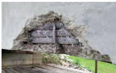
Рис. 4. Коррозия бетона мостовых конструкций в г. Соликамске.
