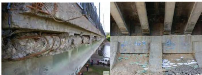
Рис. 1. Коррозия бетона на Московском мосту (г. Чебоксары).
