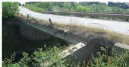
Рис. 3. Разрушение элементов моста через р. Мулянка в Пермском крае.
