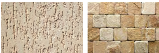
Рис. 1. а) штукатурка «Короед»; б) обработанные естественные камни.
