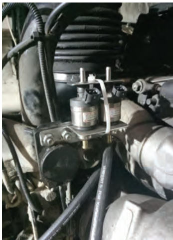
Рисунок 3. Монтаж газовых форсунок
