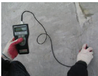
Рисунок 2 Определение влажности бетона инструментальным прибором
