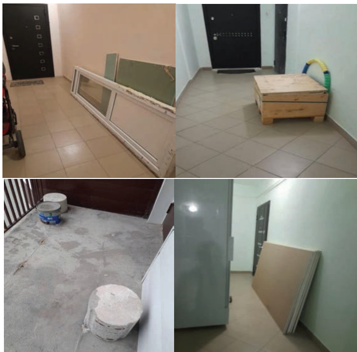
Рис. 2. Примеры нарушения хранения вещей личного пользования на эвакуационных выходах, лестничных площадках и в холлах в осмотренном многоквартирном доме
