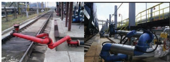
Рисунок 5. - Место локальных утечек нефтепродуктов на железнодорожной сливоналивной эстакаде
