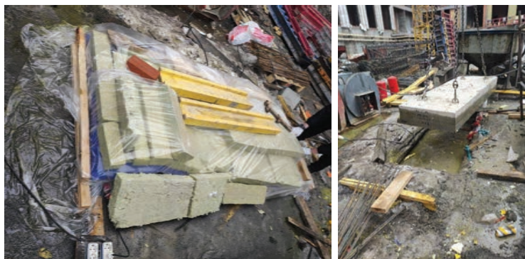
Рисунок – 2 начало и завершение процесса отогрева лестничной площадки
