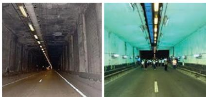
**Рис. 2. Внутренний вид туннеля Леопольда II в Брюсселе до и после реконструкции с использованием фотокаталитических материалов**
