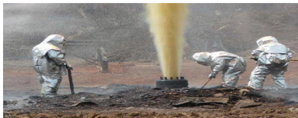
Рисунок 2. Работа аварийно - спасательной службы по ликвидации открытого фонтана нефти
