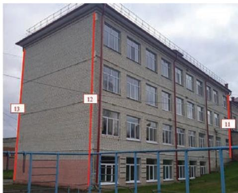
Рисунок 5 – Схема проведения геодезической съёмки здания
