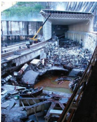
Рисунок 3 – Общий вид повреждений машинного зала Саяно - Шушенской ГЭС в результате техногенной катастрофы, произошедшей в августе 2009 года в п. Черемушки
