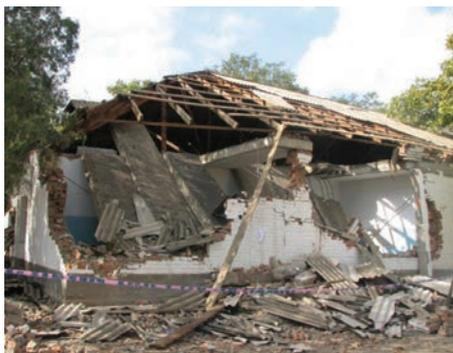
Рисунок 2 – Общий вид поврежденного здания в результате сейсмического события, произошедшего в Чеченской Республике в октябре 2008 года
