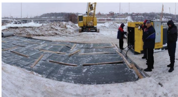
Рисунок 1 – Оттаивание грунта электроматами
