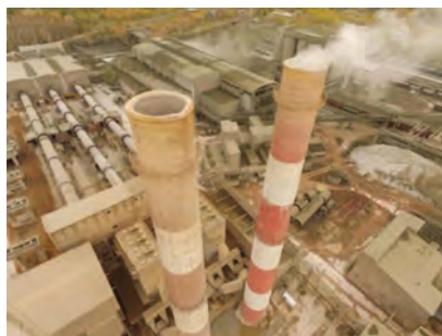
Рисунок 1. Осмотр поверхности высотных объектов
