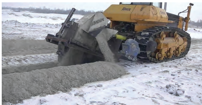
Рисунок 2 - Разработка мерзлого грунта баровой машиной
