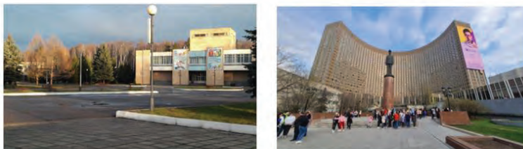
Рис. 2. Фрагмент общего вида Детского дома отдыха «Непецино» и Конгресс - центр ГК «Космос» (ст. метро «ВДНХ»)
