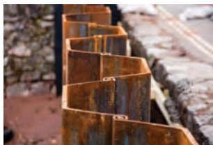
Рисунок 2. Пример ограждения, выполненного из металлического шпунта
