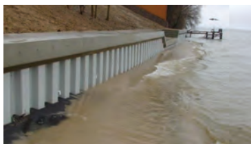
Рисунок 1. Пример ограждения, выполненного из ПВХ – шпунта
