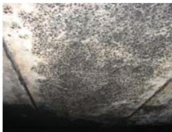
Рис. 1. Изрезанная и отколотая нижняя сторона жб. Балки (Т. 150°C - 200°C)
