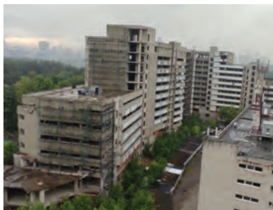
Рисунок 1 – Общий вид здания – «объекта незавершенного строительства»
