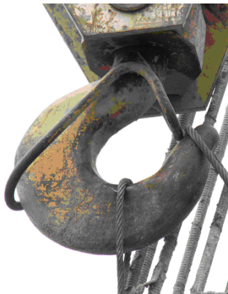
Рис. 1. Выход стропа из крюка крана КС- 6476
