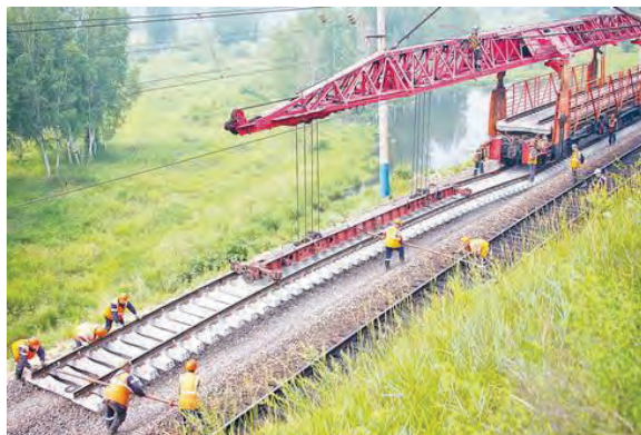
Рис. 1. Капитальный ремонт железнодорожного полотна
