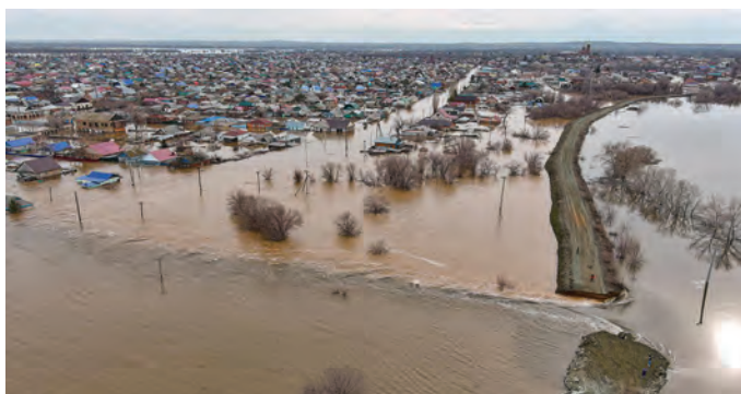
Рисунок 1. Разрушение дамбы и затопление прибрежных территорий вследствие паводка в Оренбургской области 09 апреля 2024 г.
