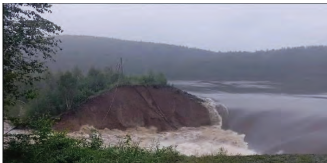
Рисунок 2. Разрушение дамбы и затопление прибрежных территорий вследствие аномальных ливней в Челябинской области 26 июля 2024 г.
