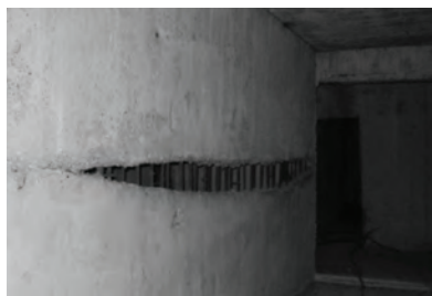
Рисунок 1 - Дефект бетонирования
