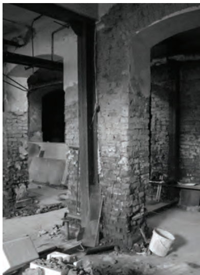
Рисунок 4 – Усиление несущих конструкций
